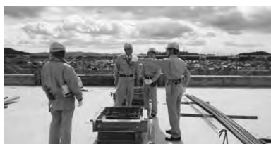
屋上配線：旭電業
