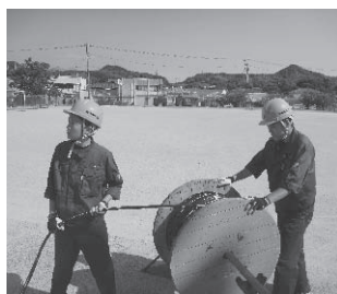
ケーブル敷設：報国電設
