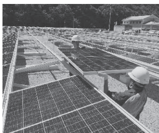
ソーラーパネル据付：カジノン
