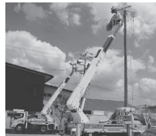
復旧電気工事中(株)中電工
