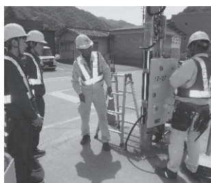
信号修理：三恭電設
