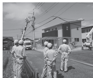
電柱作業：旭電業
